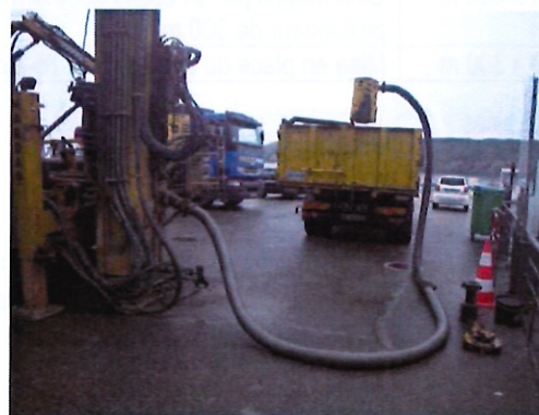
Principe de montage pour l'évacuation des cuttings
