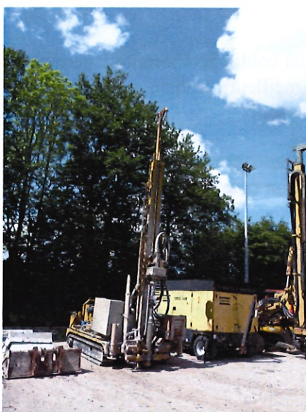
La foreuse et le compresseur qui devraient être utilisés
